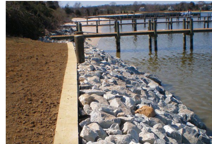
護岸を使用した低く盛り上がった水辺の例
