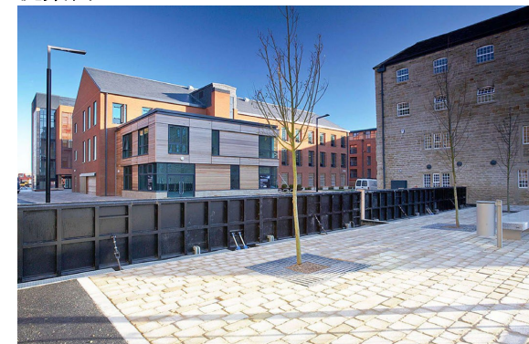
上昇式バリアの形式による小規模可動式防御の例。通常の状態では、上昇式バリアは下に跳ね返されて隠れます
