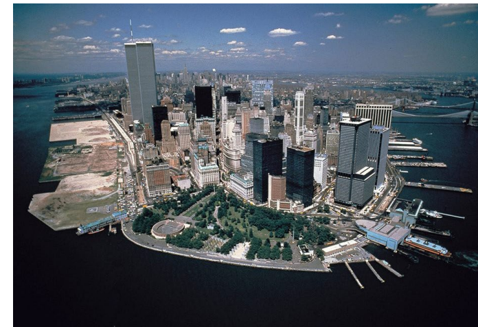
拡張エリアの先例～バッテリーパークシティ(1973年)の土地埋め立て～。当時はレジリエントのある設計が組み込まれていなかった。
