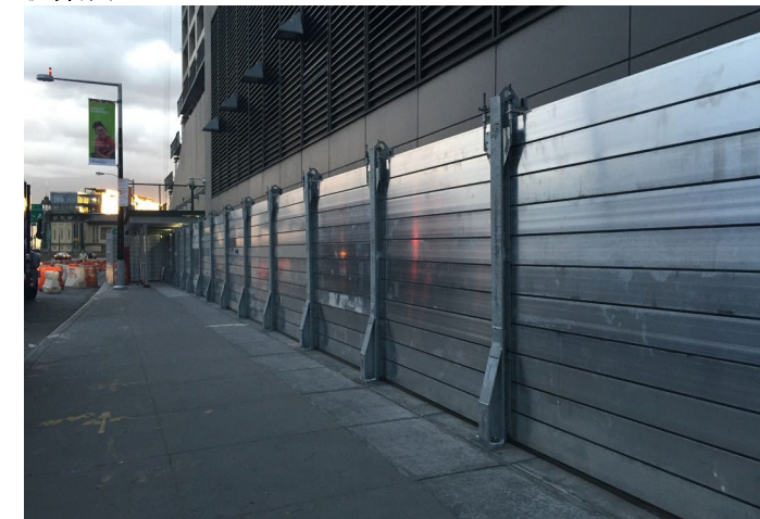
ロウアー・マンハッタンの建物の乾式耐水対策の例
